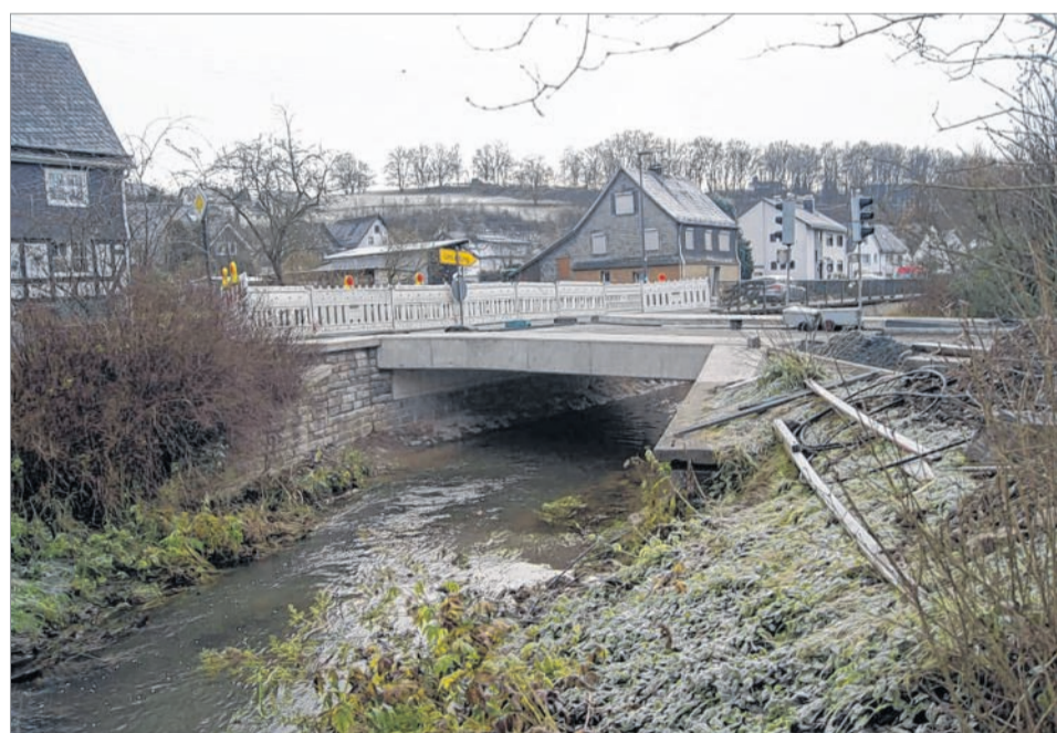
Die neue Brücke an der Hanfwiese liegt nach Angaben des Bürgermeisters „voll im Bauzeitenplan“. Falls nicht ein dauerhafter Winterereinbruch einen Strich durch die Rechnung macht, soll die Brücke noch in diesem Jahr fertig werden. Foto: ihm
